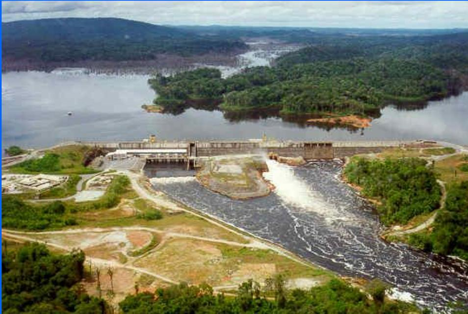
**Puissance électrique : 4 turbines de 29 MW (116 MW)**
